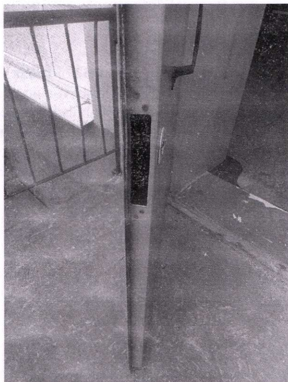
Фото 1,2 обеспечение возможности свободного открывания запоров дверей эвакуационных выходов изнутри без ключа.
