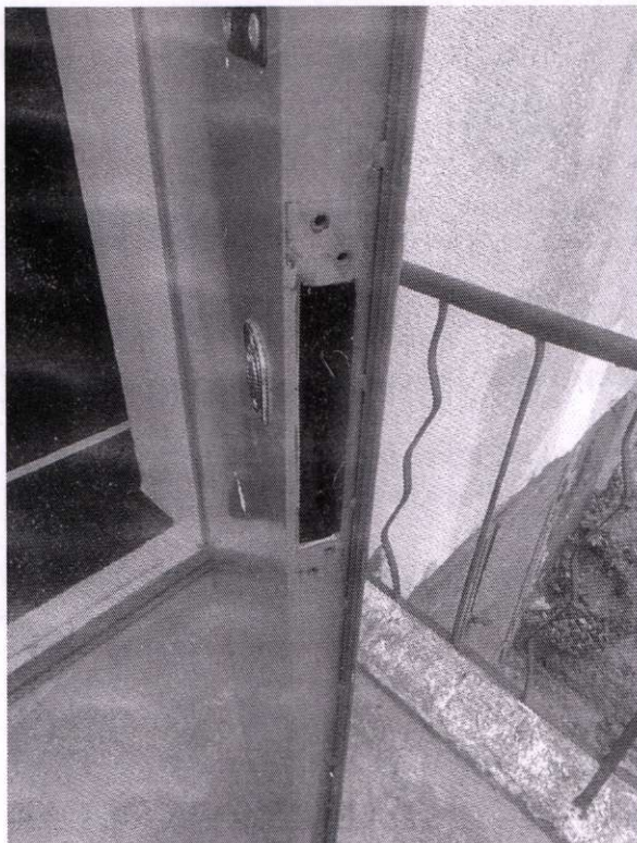
Фото 1,2 обеспечение возможности свободного открывания запоров дверей эвакуационных выходов изнутри без ключа.
